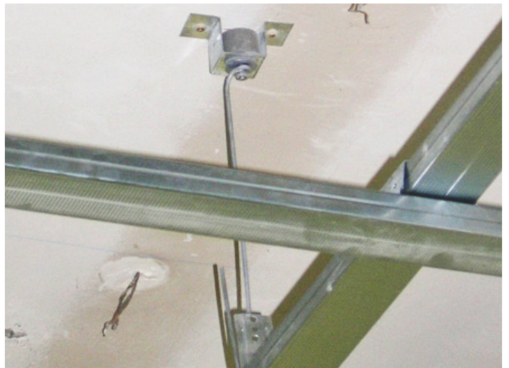
Крепление Vibrofix SP с регулируемым подвесом на спице
