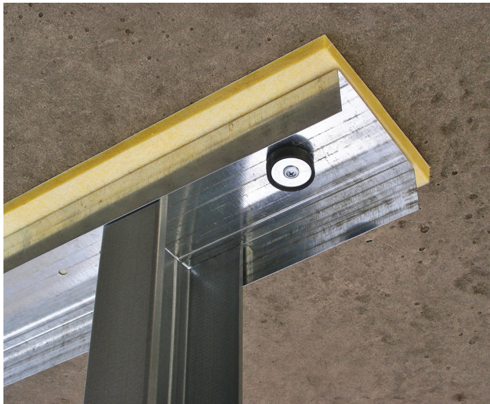
Монтаж звукоизоляционной перегородки с применением звукоизолирующего направляющего профиля Vibrofix Liner 100
