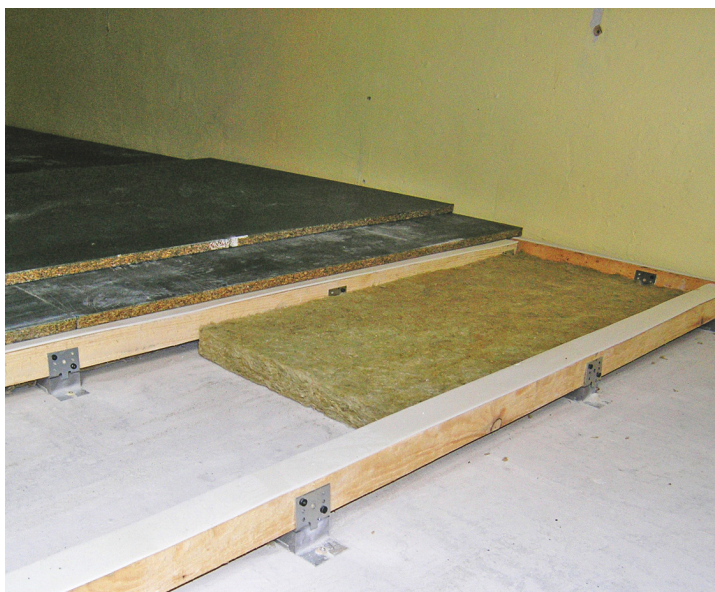
Монтаж плавающего пола по деревянным лагам с применением креплений Vibrofix Floor
